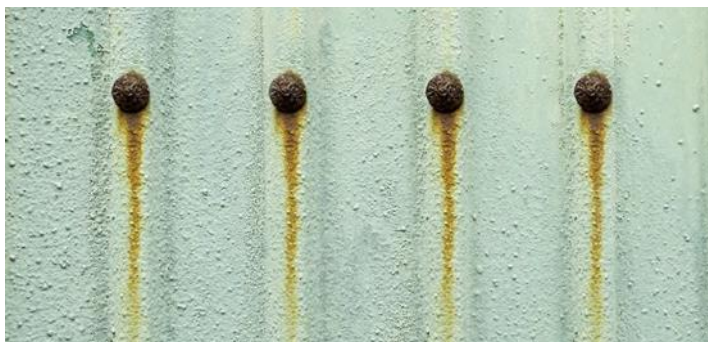
Obr. 1: Příklady galvanické koroze [1, 2]
